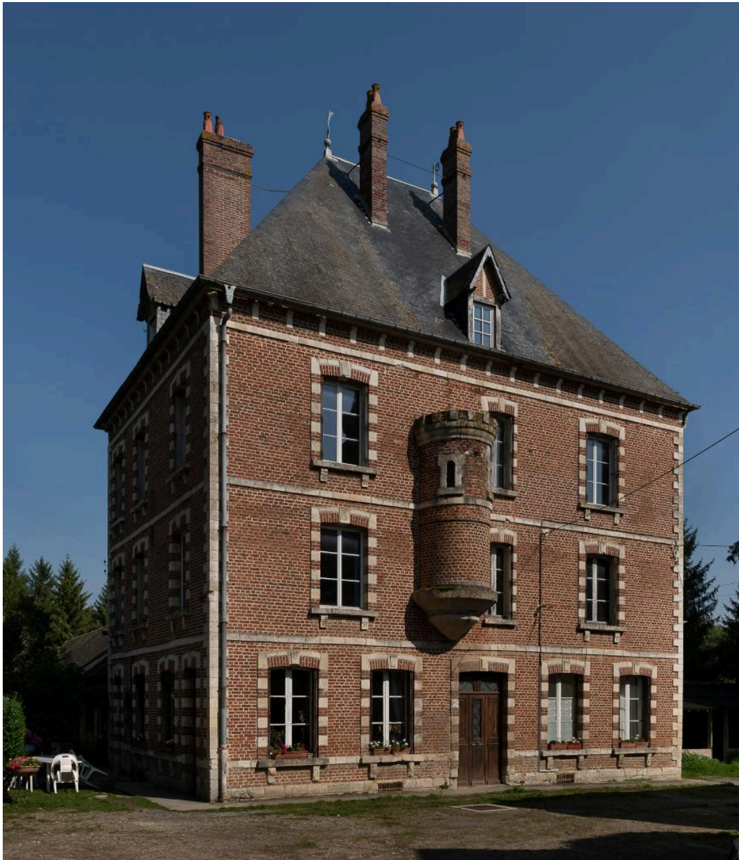
Vue du pavillon sud depuis le sud.
