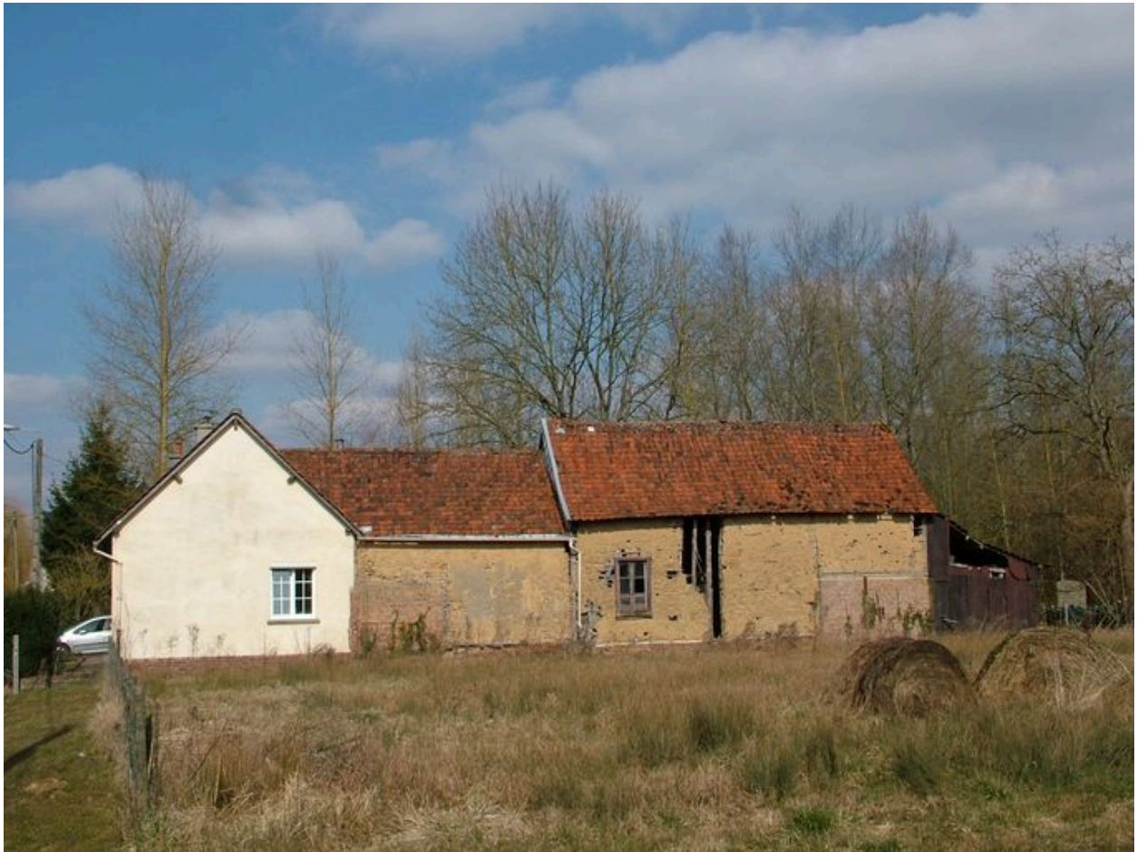
Canaples, ancienne ferme, 183 rue de l'Étroit, présentant des bâtiments d'exploitation en torchis, 1 ère moitié du 19 e siècle.
