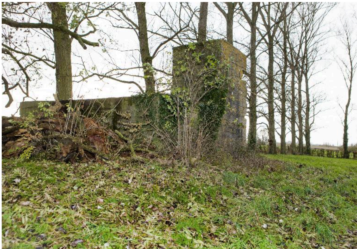
Vue latérale, vers l'ouest
