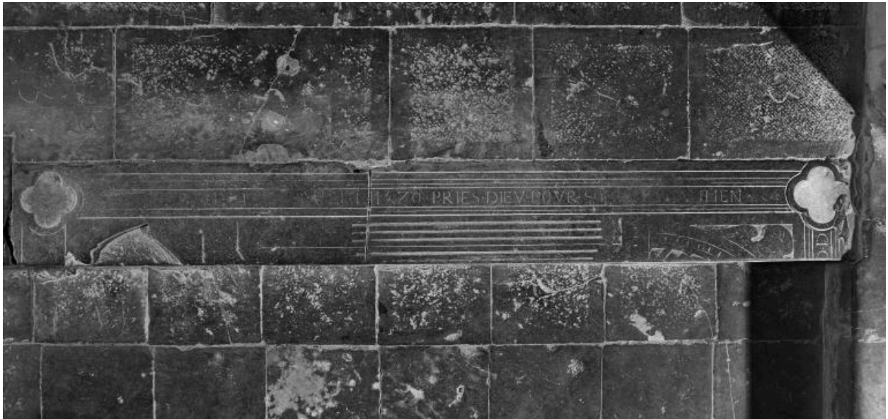
Elément de la dalle.
