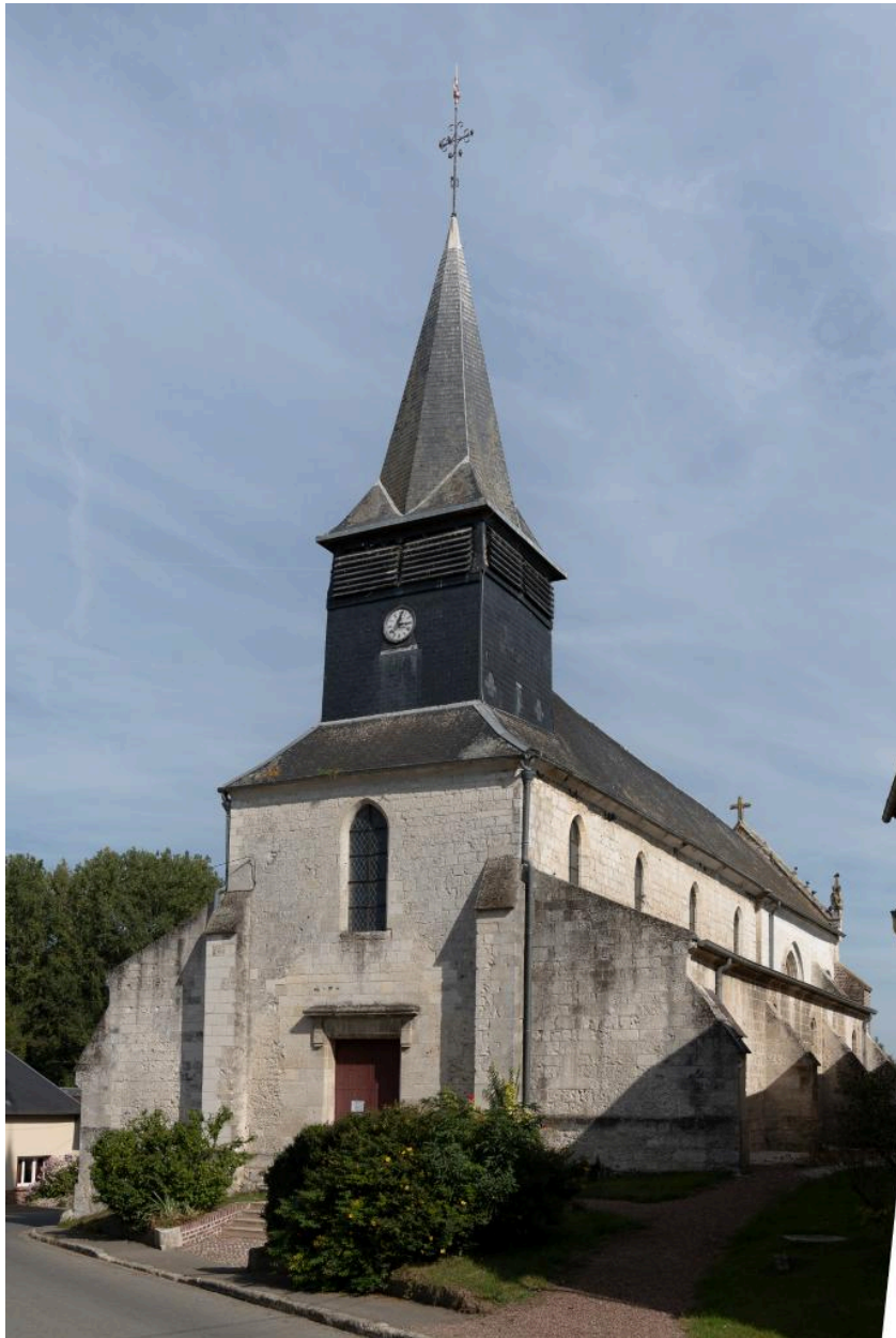
Vue de la façade occidentale.
