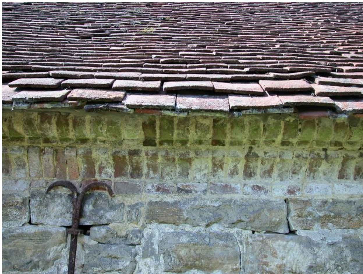
Détail de la corniche moulurée.
