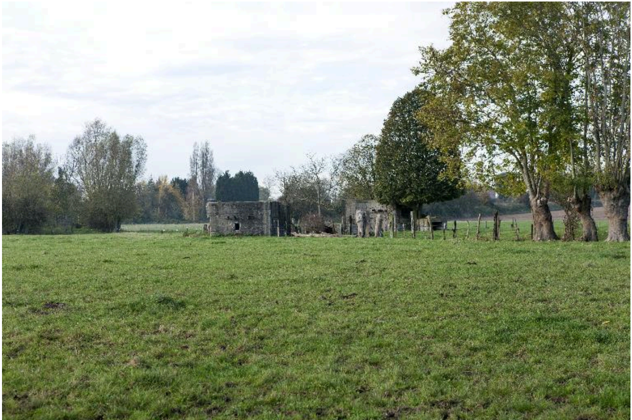
Vue le nord-ouest, depuis le chemin de l'Aventure
