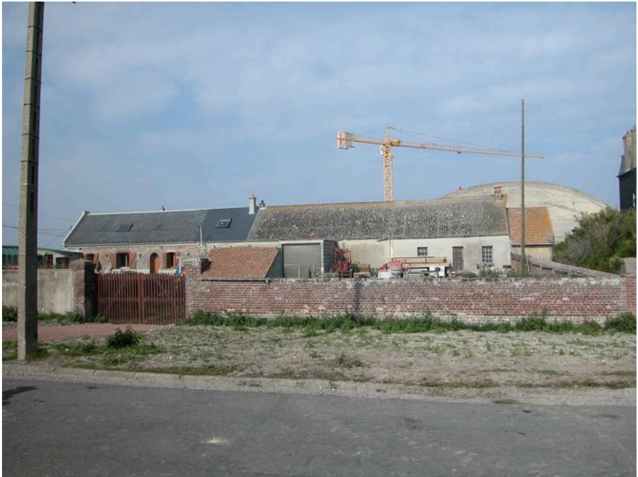
Bâti ancien proche de la plage, 52 rue Florent-Triquet (1988 AY 238).
