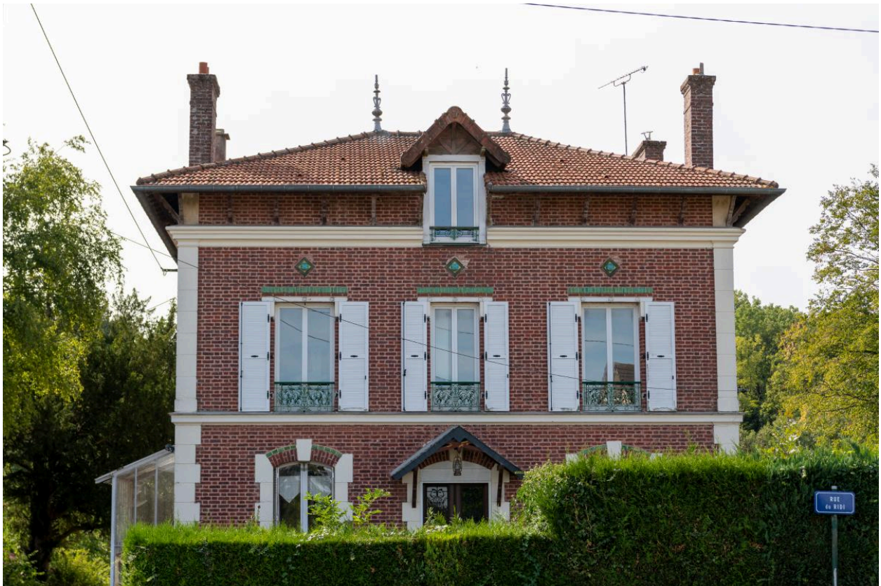
Maison de notable, n°2 rue Marcel Dassault, vue depuis le nord.
