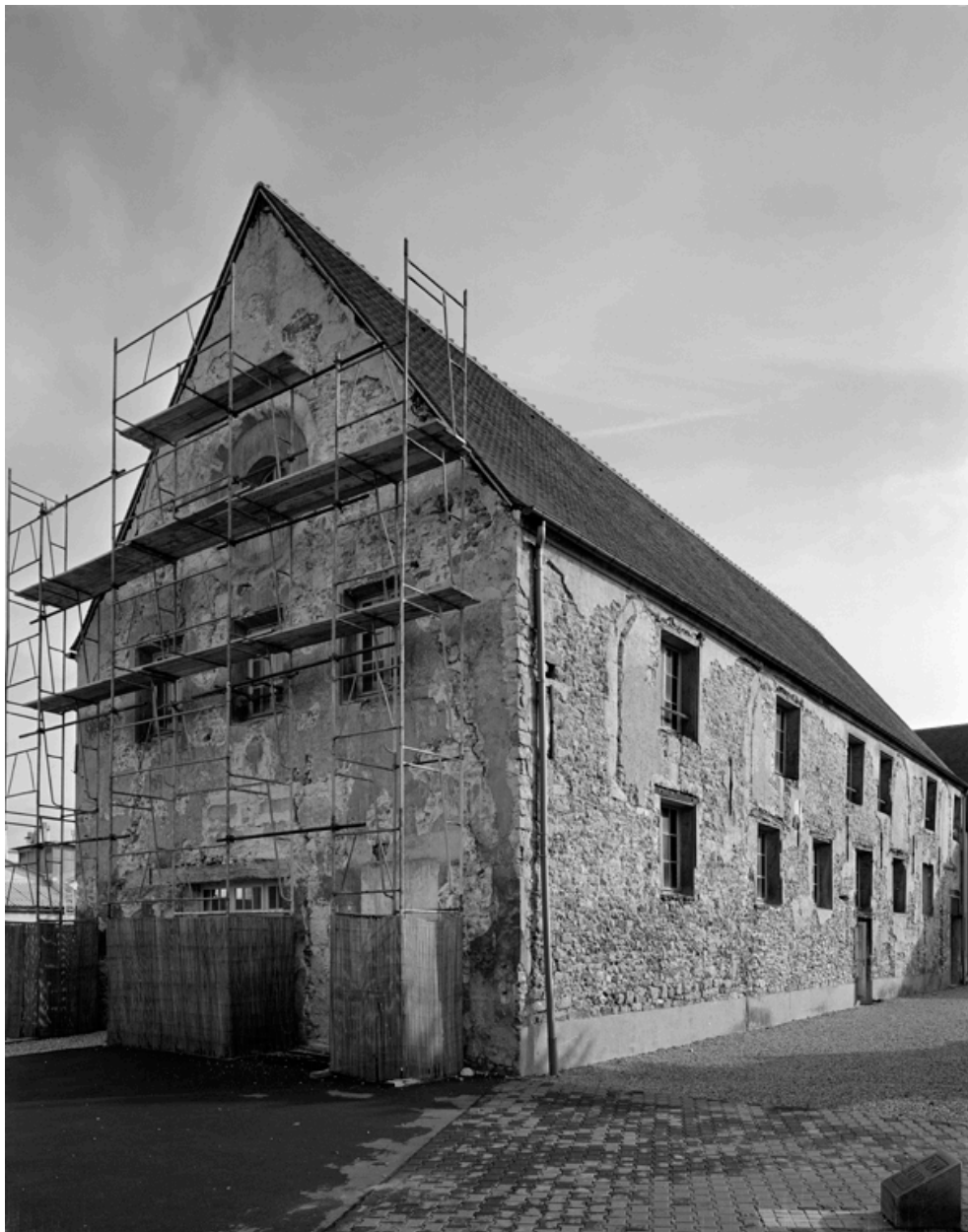
Le pignon de l'ancienne chapelle, en cours de travaux.
