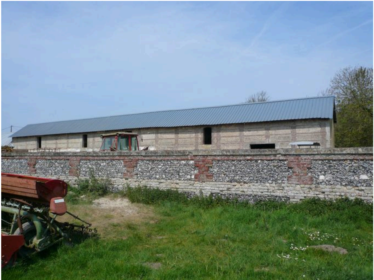
Vue sur le mur intérieur de la cour.
