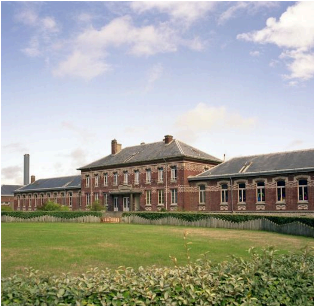
Bâtiment d'isolement des enfants contagieux ajouté en 1909 sur l'arrière de l'édifice primitif, élévation antérieure, vue de trois-quarts droit,
