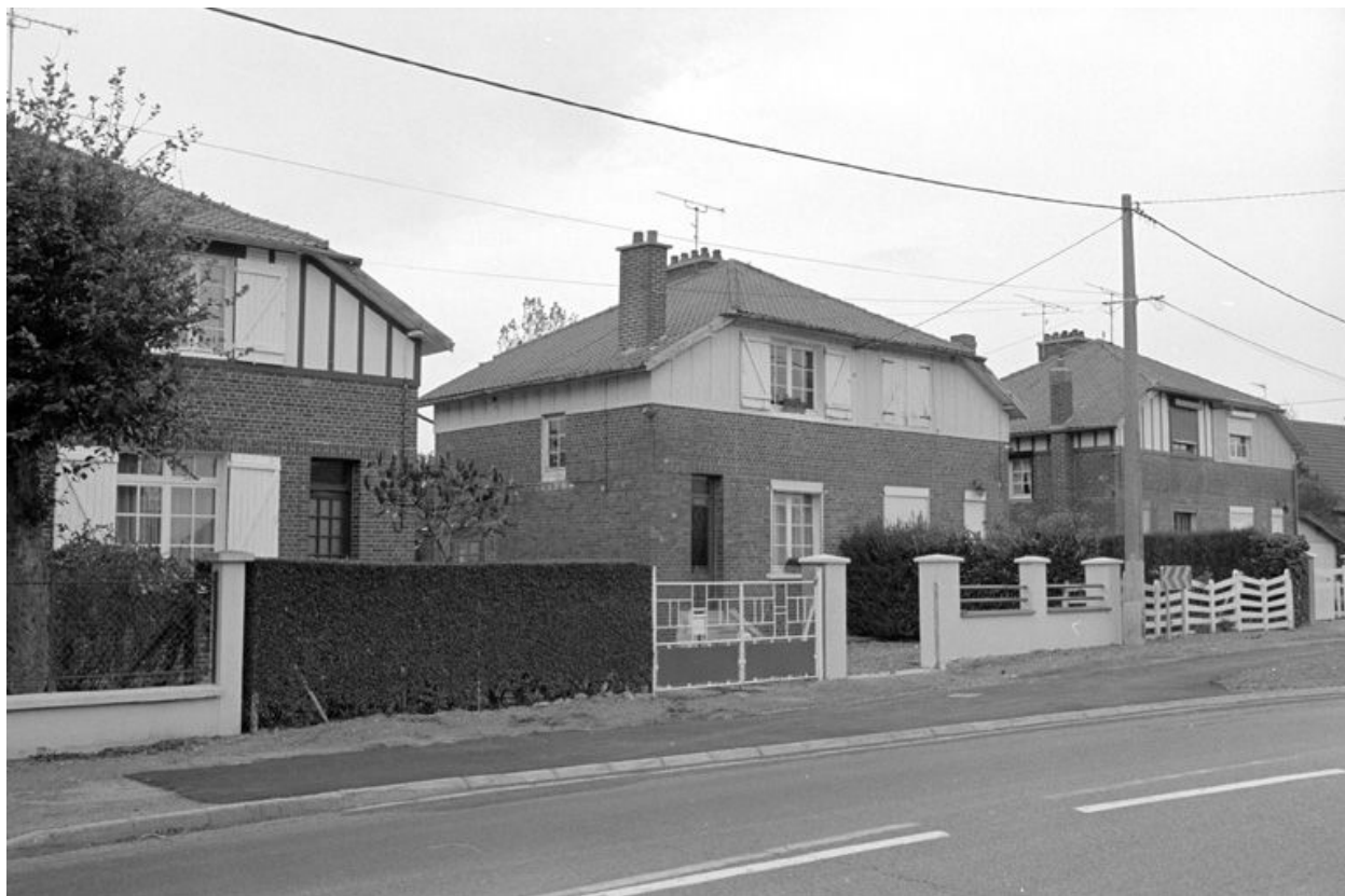
Logement d'ouvriers, vue d'ensemble.
