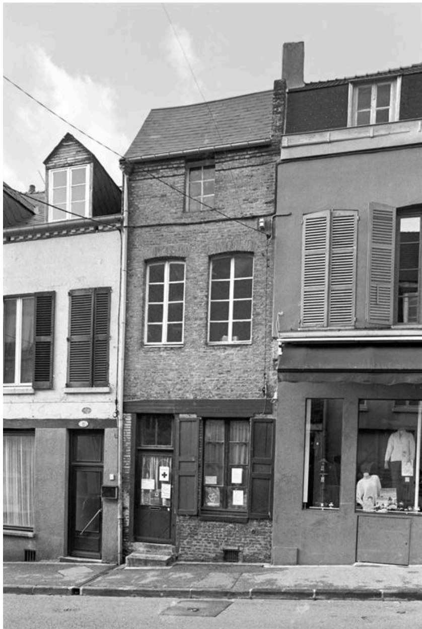
Vue de la façade principale sur rue.
