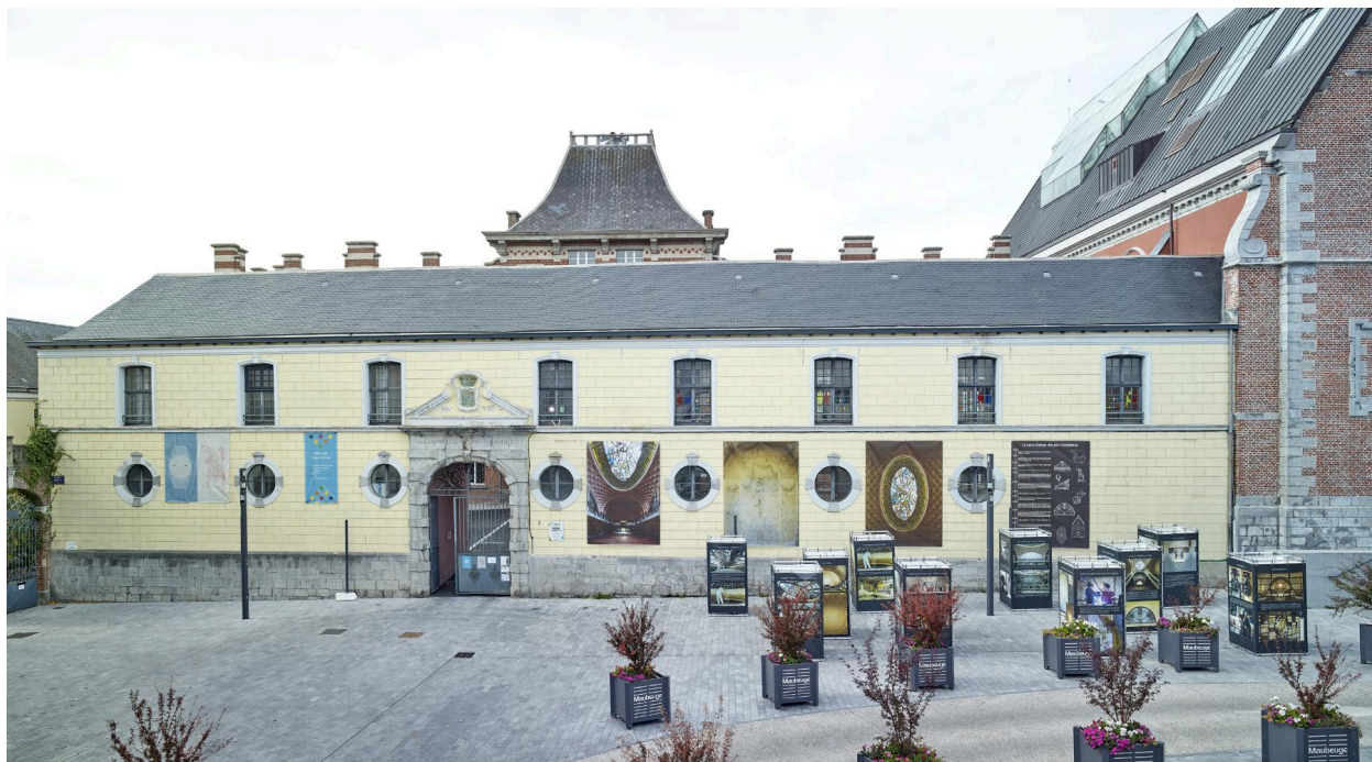
Vue de l'aile orientale depuis l'est.
