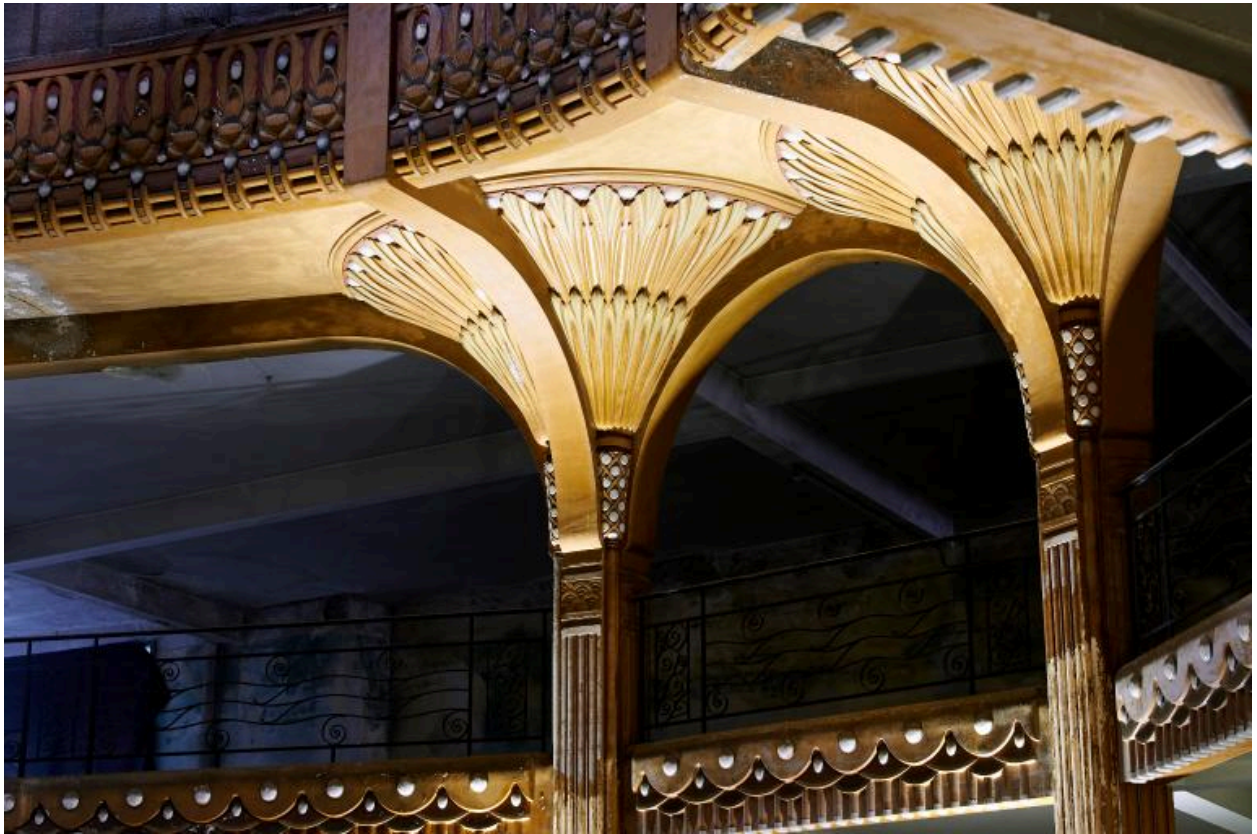
Décor du couronnement des supports de l'atrium ovale, vue générale.
