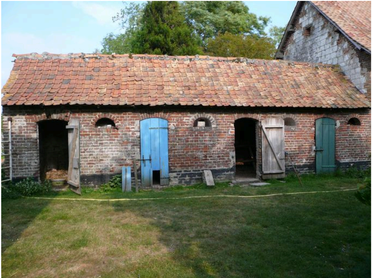
Vue des étables à cochons dans le prolongement nord des écuries.
