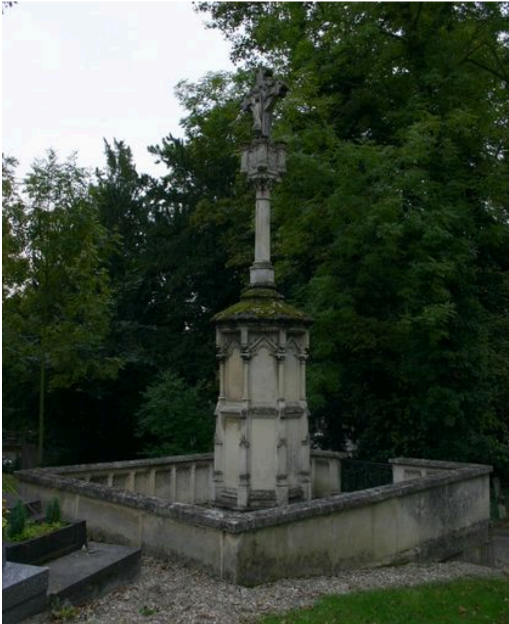
Vue générale (face postérieure).
