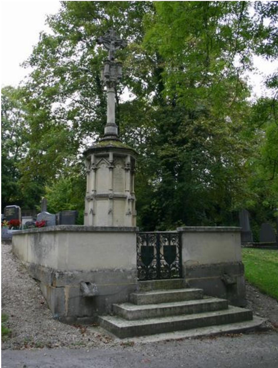
Vue générale (face antérieure).
