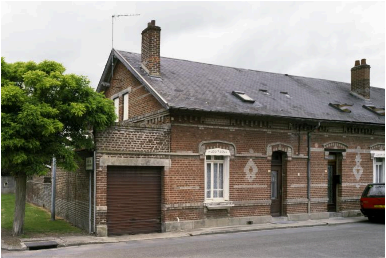
Vue de la façade sur rue de la maison n°43.
