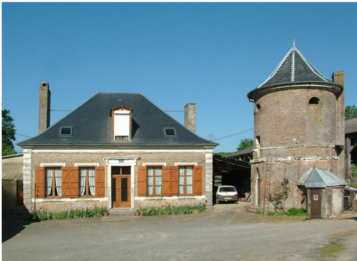
Vue de la cour avec logis et colombier.
