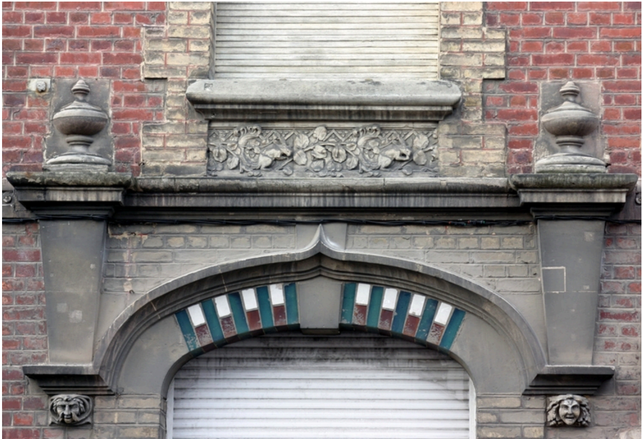
Façade, 2 rue du Général Foy : détail.
