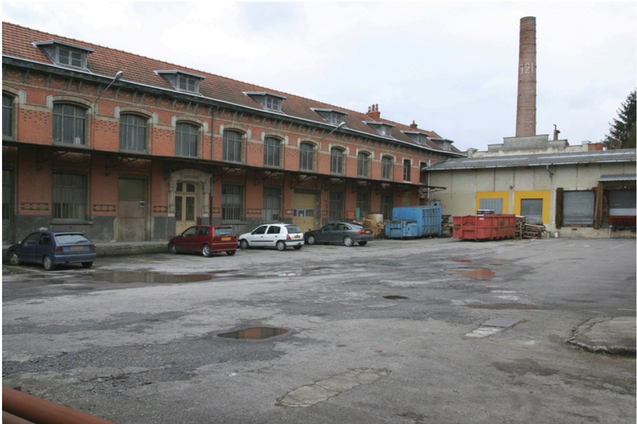
Cour de l'usine, bureaux et quai de reception des fils, et cheminée d'usine au pied de laquelle on devine la façade de la salle des machines.
