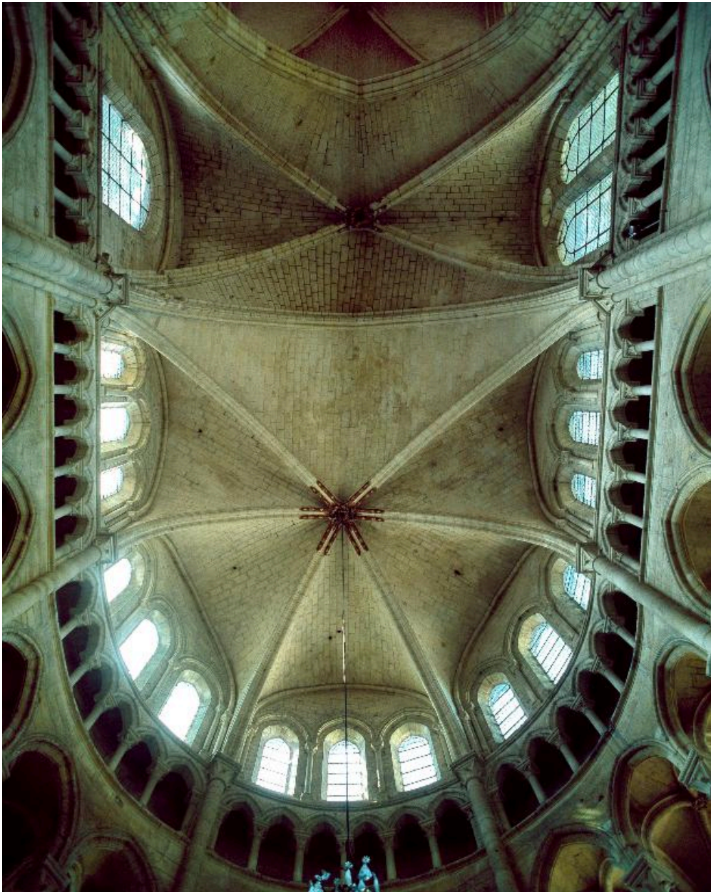
Vue de la voûte du bras sud du transept.
