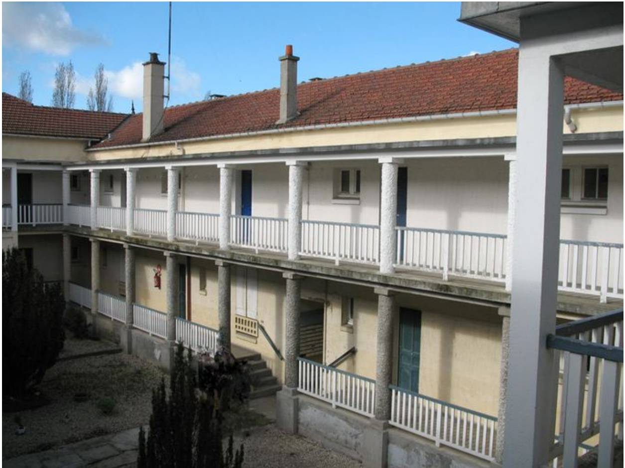
Bâtiment 520 : Détail de la coursive intérieure.
