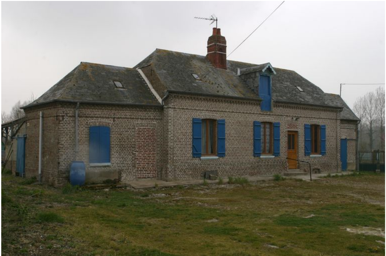
Vue du logis depuis la rue.
