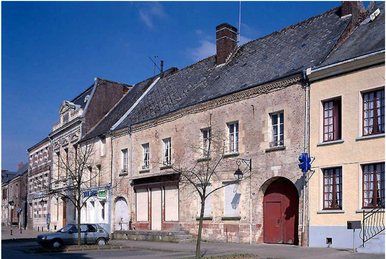
Vue depuis le sud-est.
