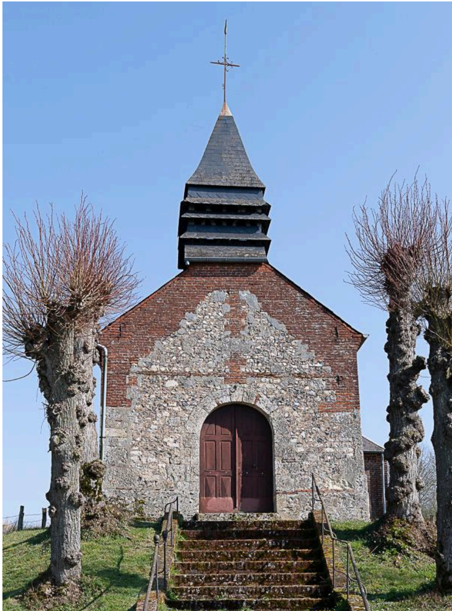
Vue de la façade occidentale.
