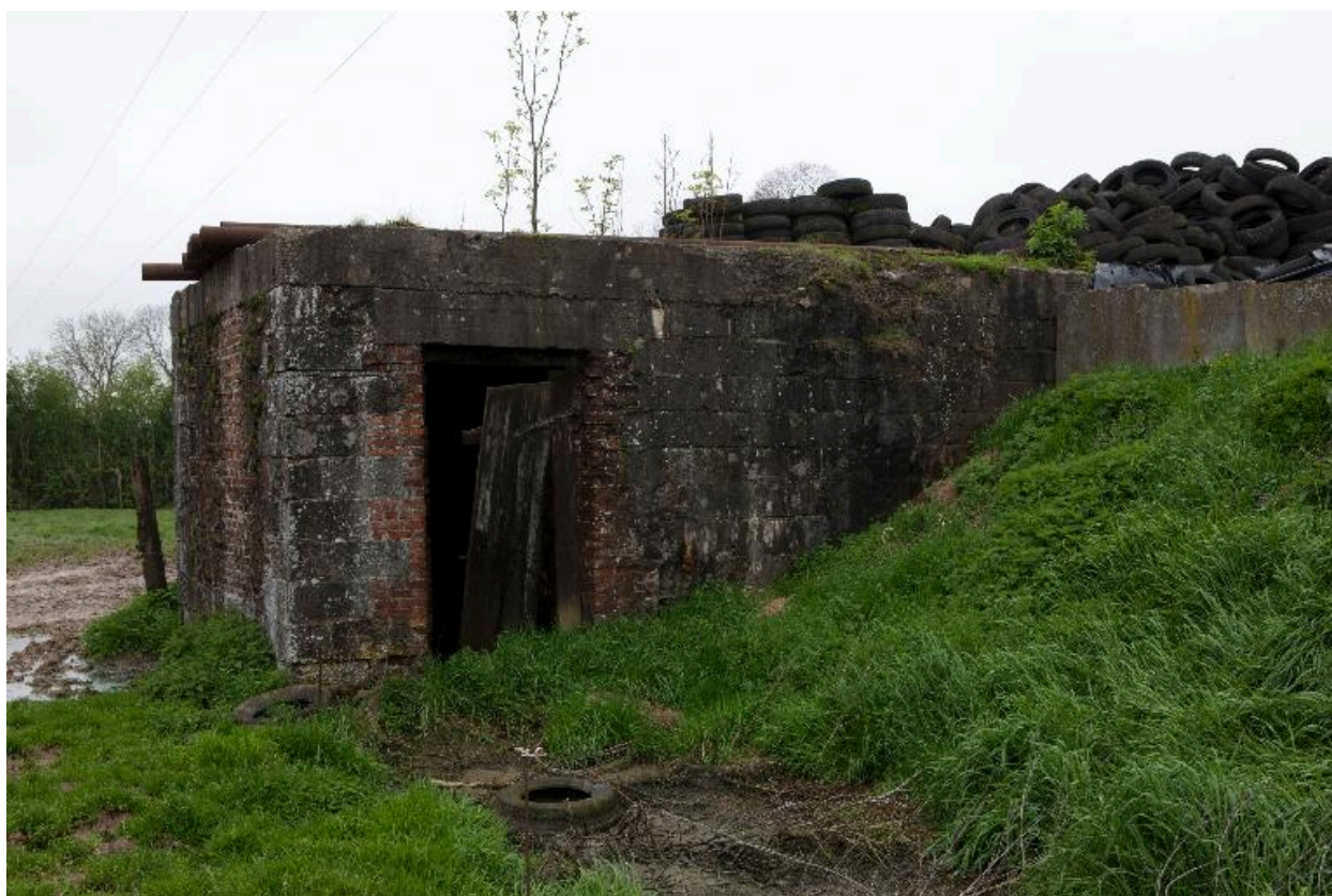
Premier abri de stockage en forme de ski. Vue de détail de la porte.
