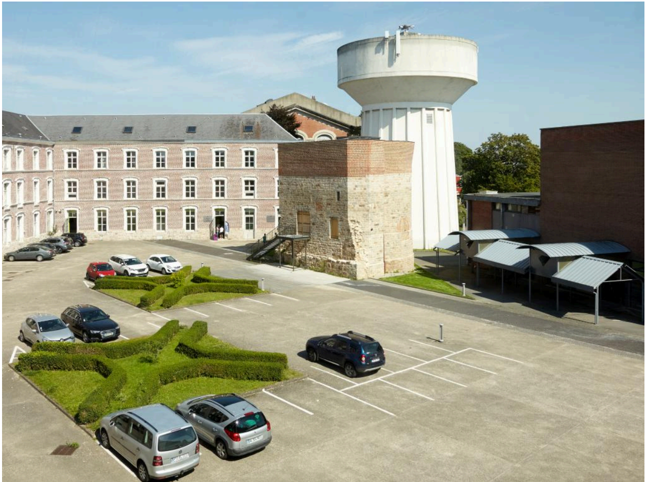
Vue générale du nord-ouest de la tour, prise depuis les étages de la tour.
