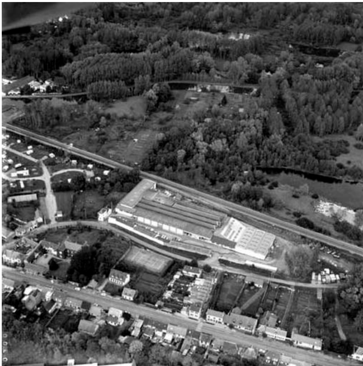
Vue aérienne, flanc sud.
