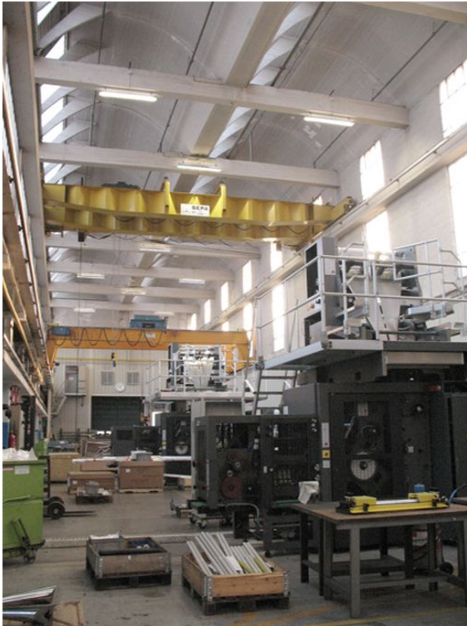
Intérieur des ateliers de l'usine sous les sheds ovoïdes.
