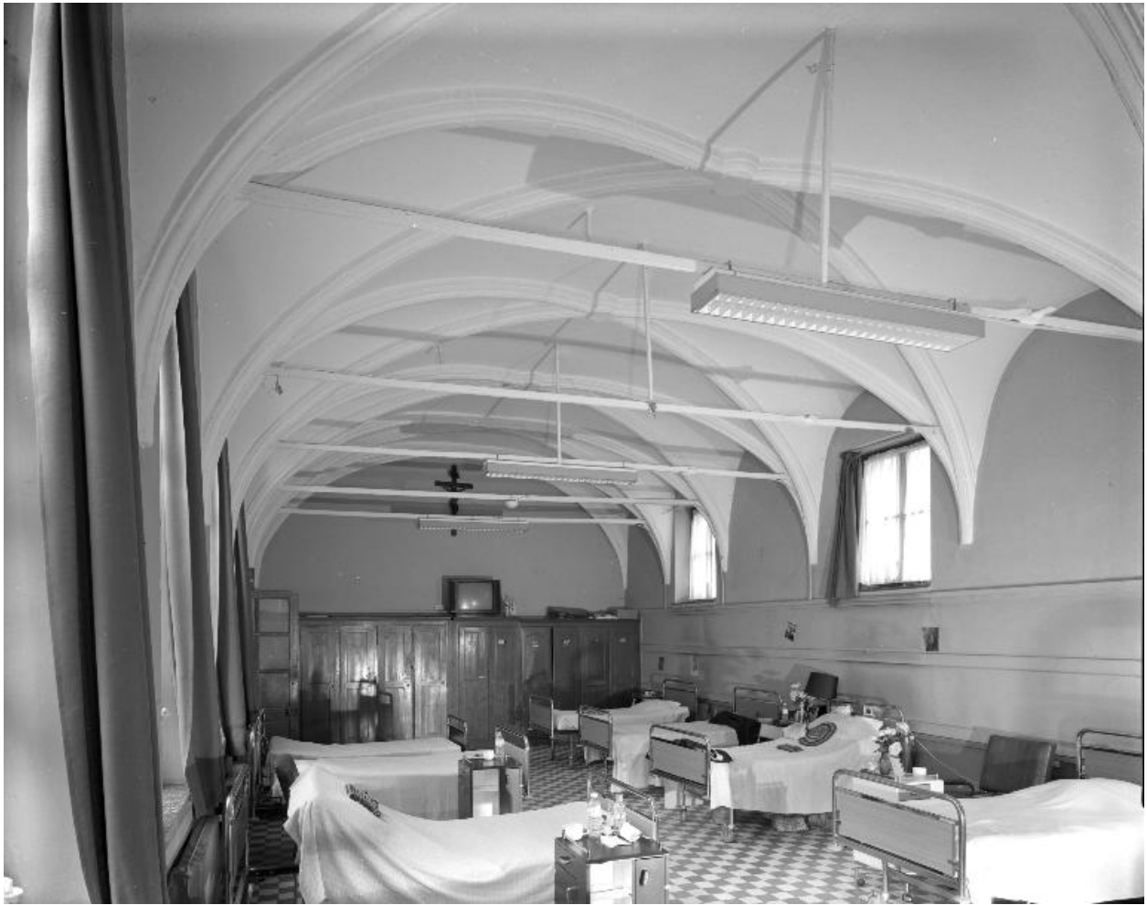
Bâtiment bordant le côté sud de la cour de service, rez-de-chaussée, salle dite dortoir Saint-François, vue générale.
