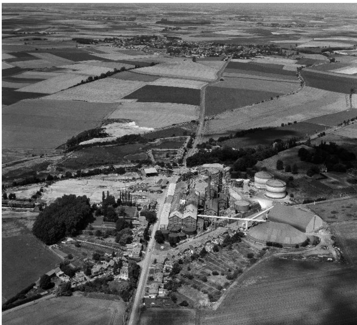
Vue aérienne, flanc sud.
