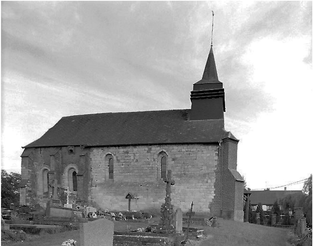
Elévation nord de l'église depuis le cimetière.
