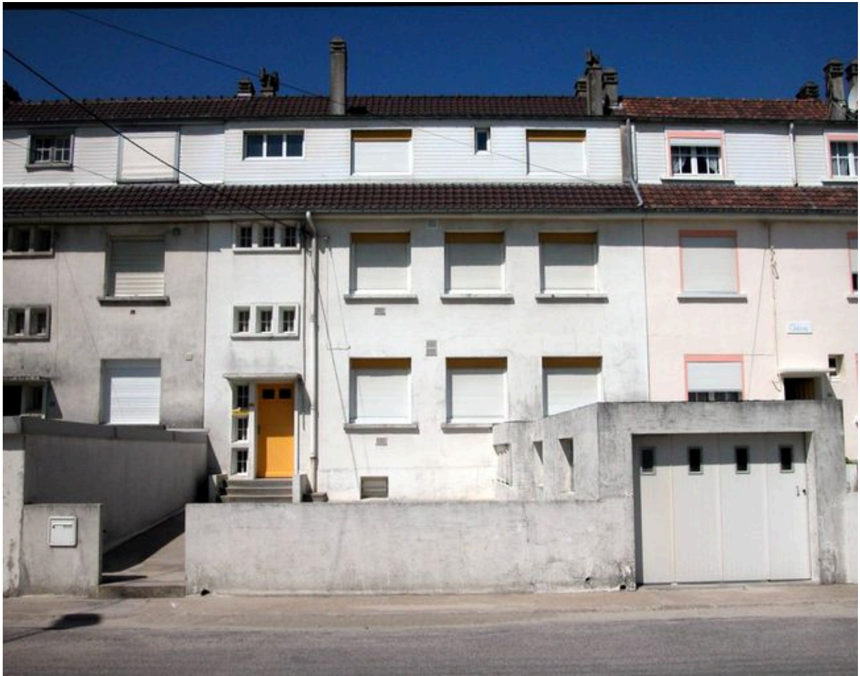
280 boulevard maritime sud (Calypso), façade d'entrée.
