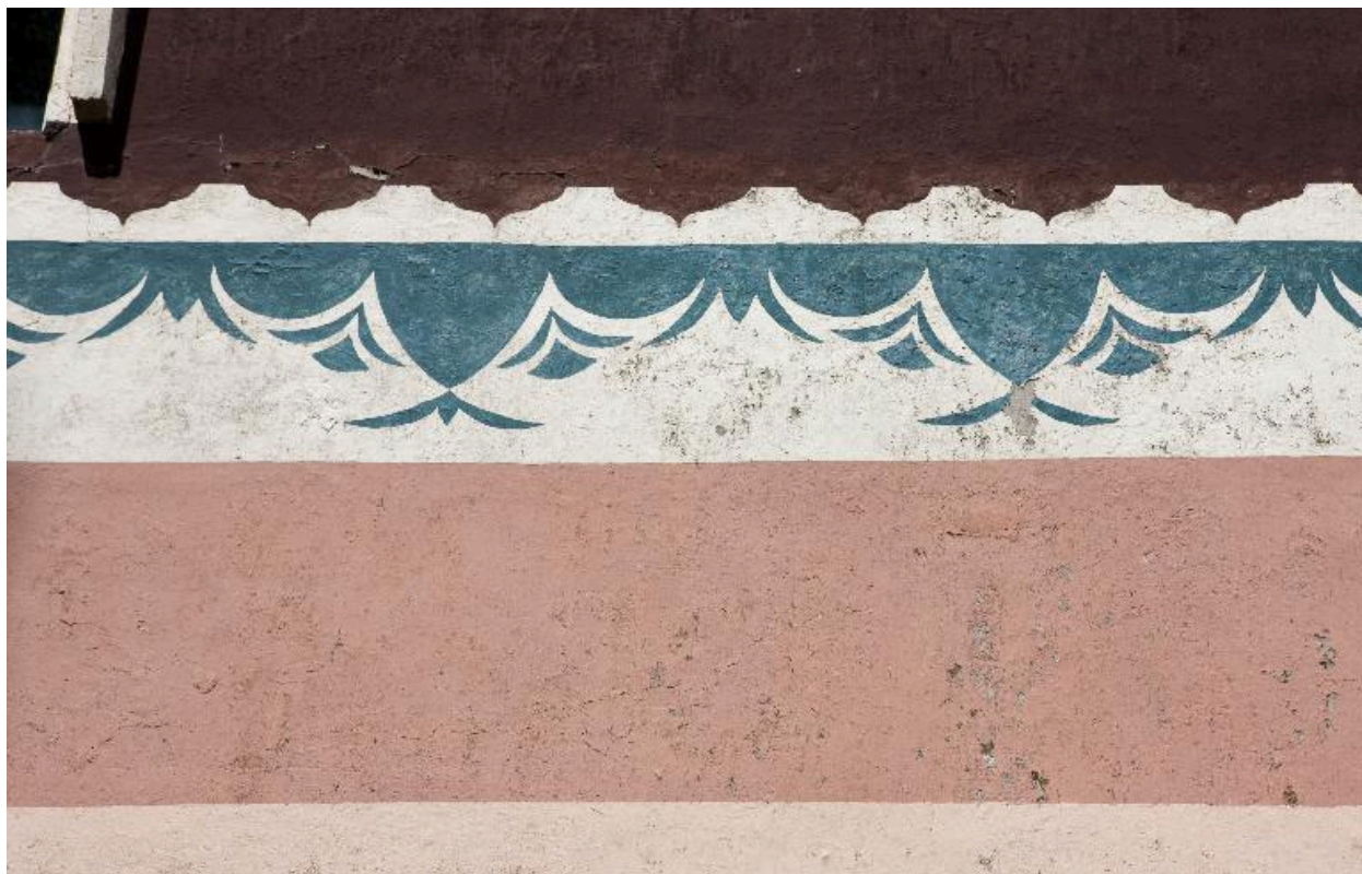
Mur de la maison, détail.
