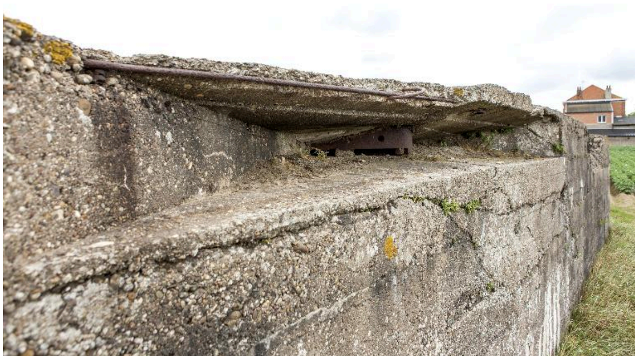
Elévation ouest : Large embrasure de surveillance en direction du front
