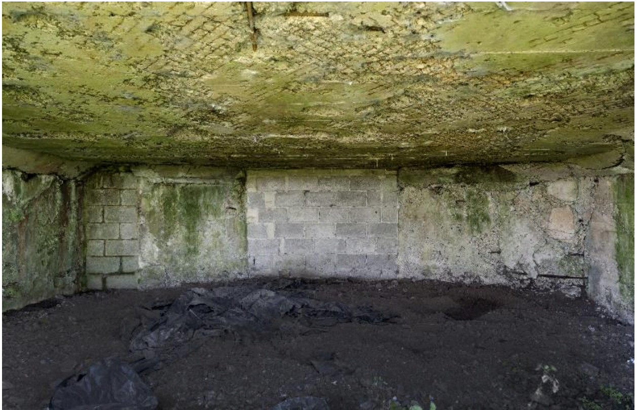
Vue intérieure de la chambre de tir, vers le sud-est.
