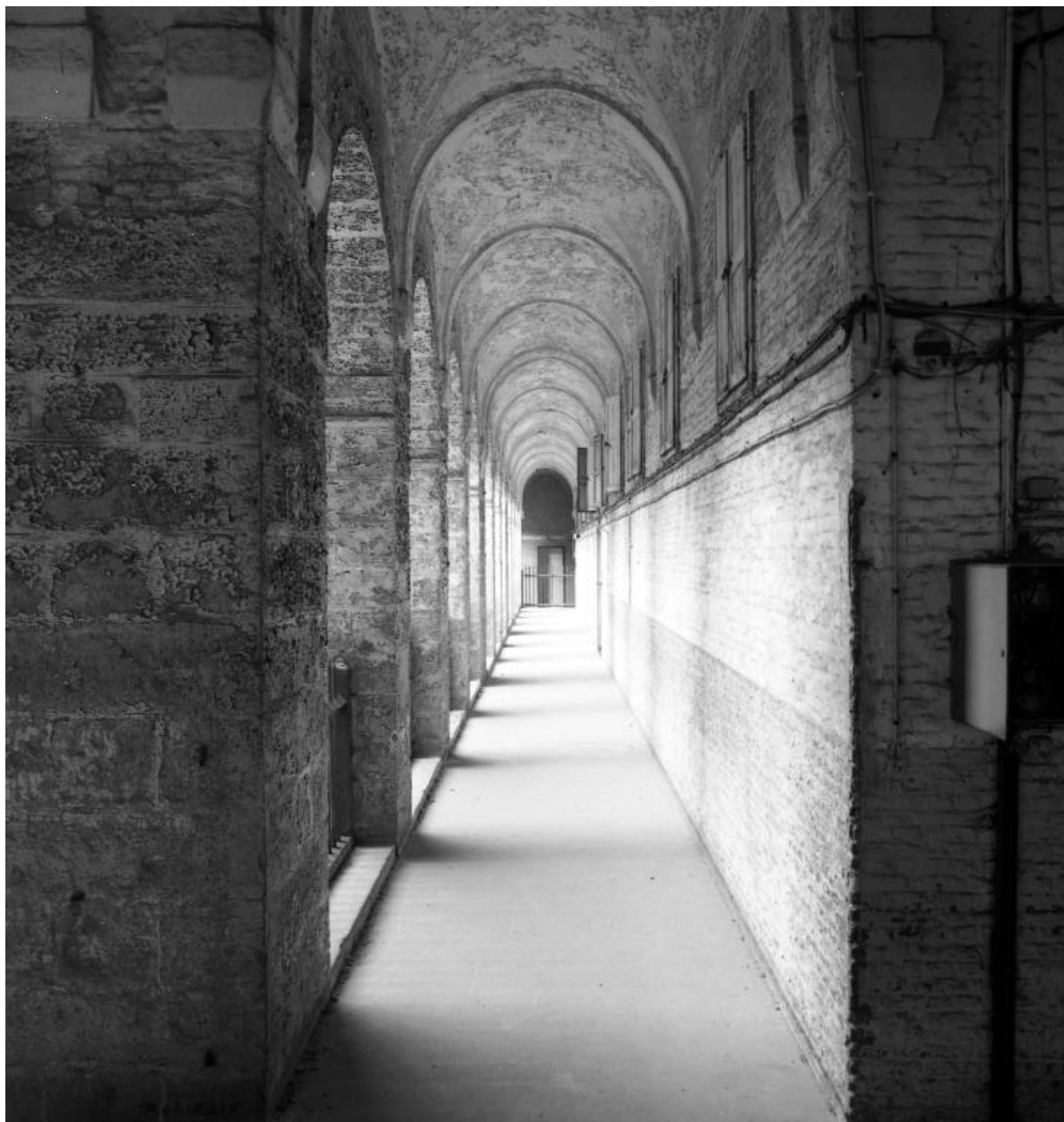
Rez-de-chaussée, galerie de distribution d'un des bâtiments bordant la cour d'honneur, vue en enfilade.
