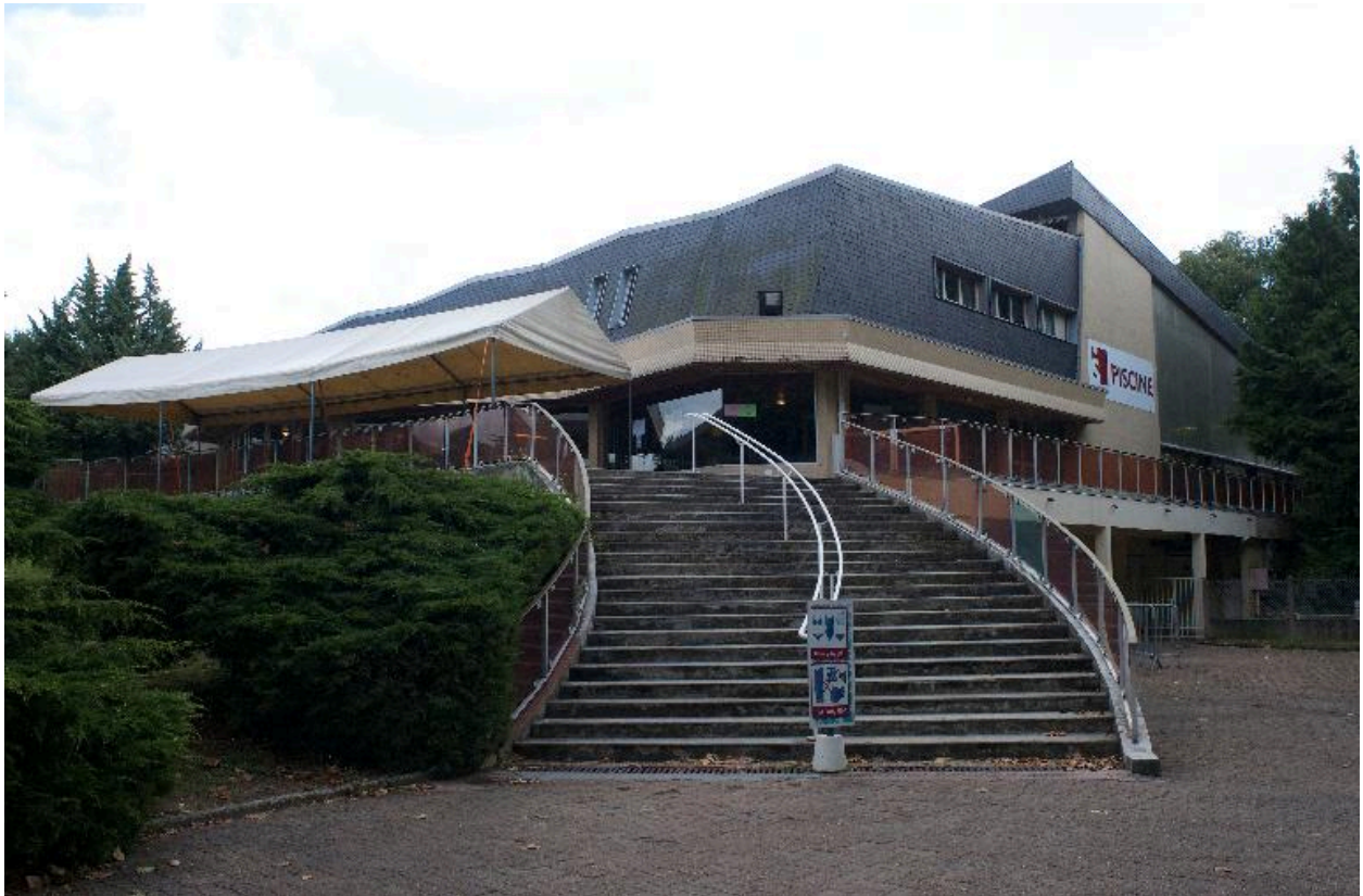
Escalier menant à la terrasse d'entrée de la piscine.
