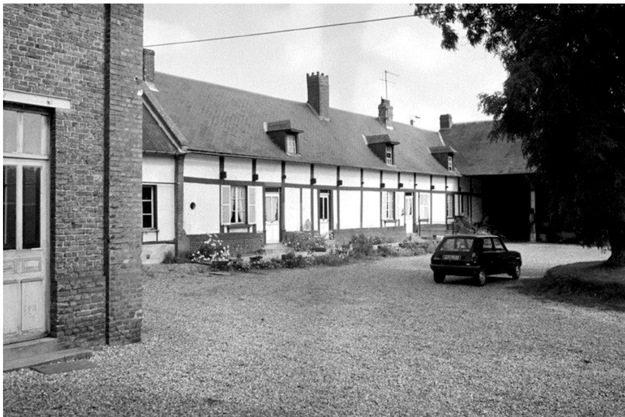
Cour, bureau et logement d'ouvriers, élévation antérieure.
