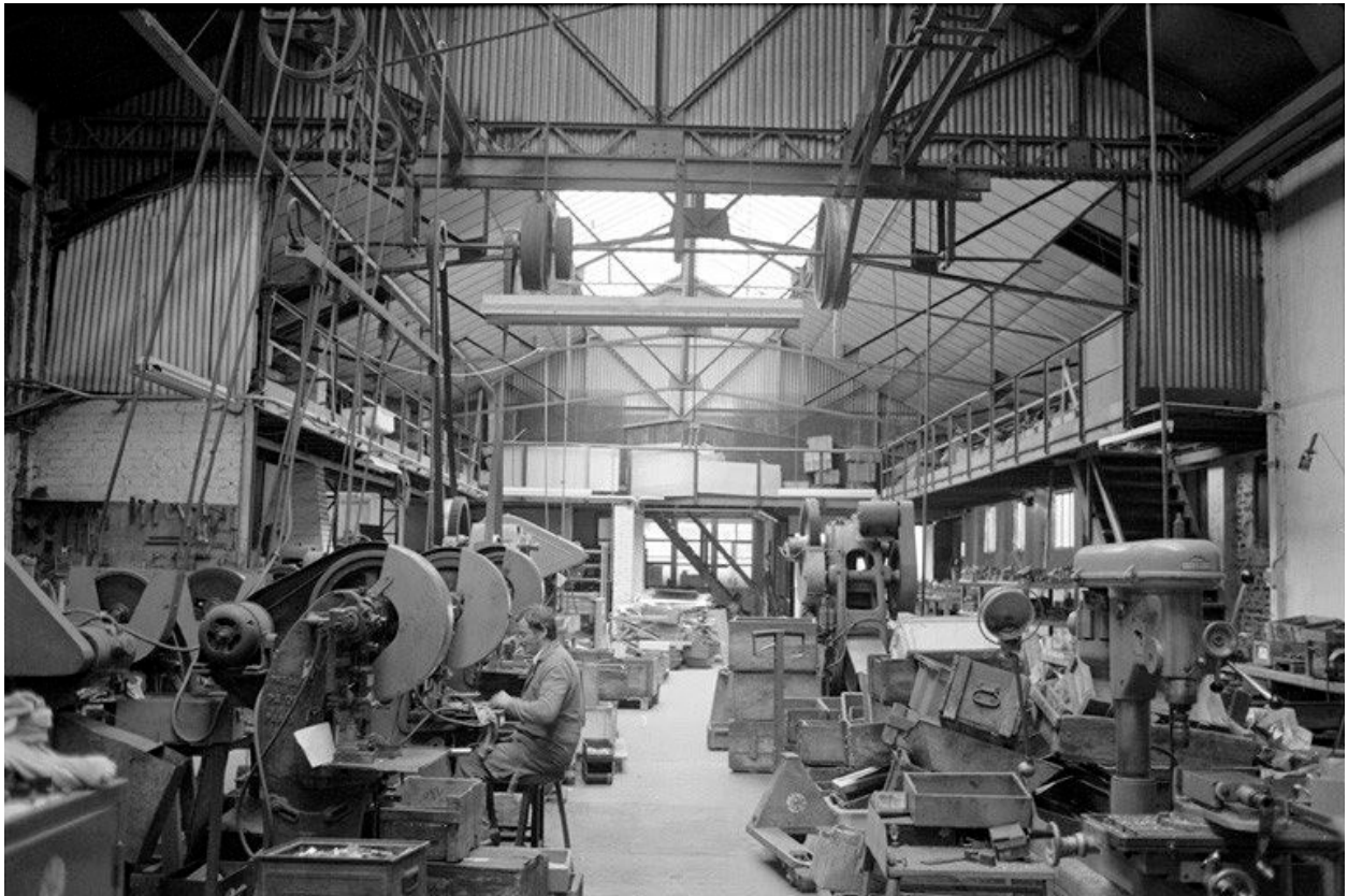
Atelier de fabrication, vue intérieure en 1990.
