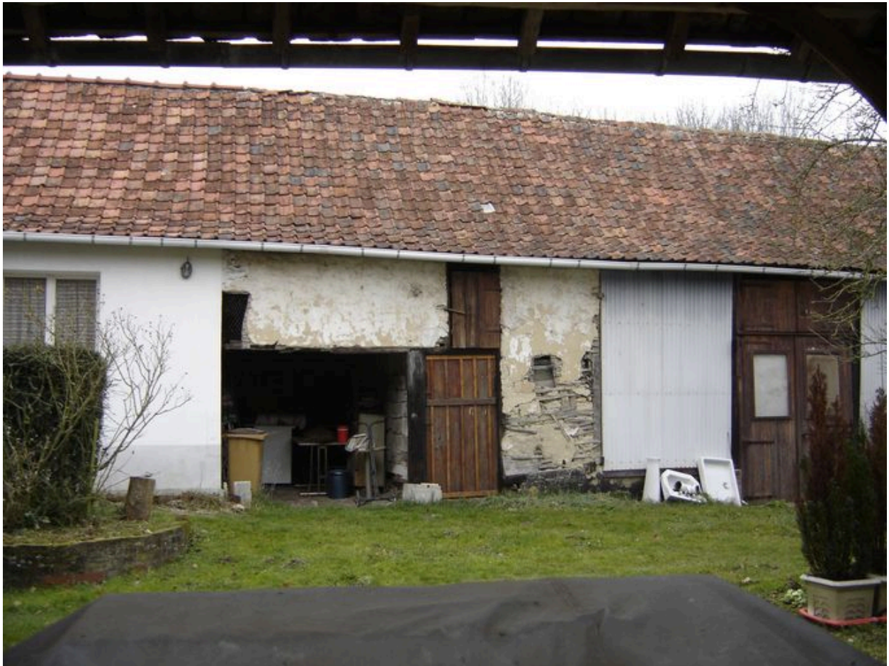
Vue du bâtiment agricole situé dans le prolongement du logis en fond de cour.
