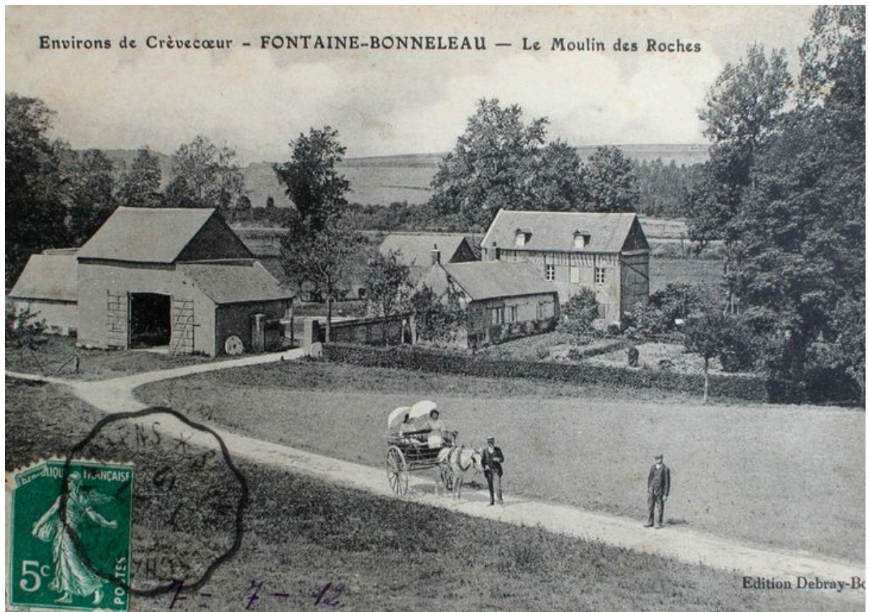
Vue d'ensemble du moulin des Roches en 1912.
