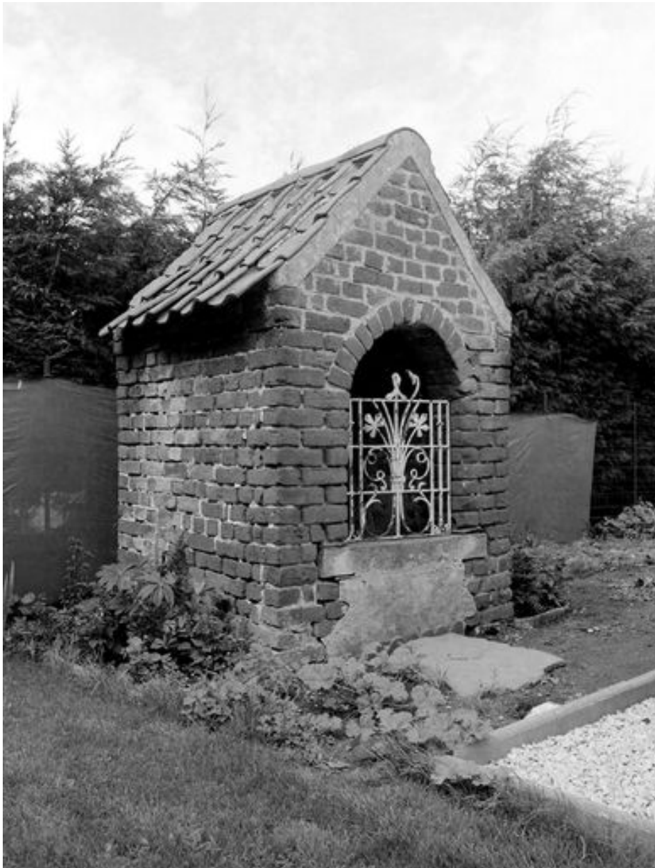
Vue générale du puits B.
