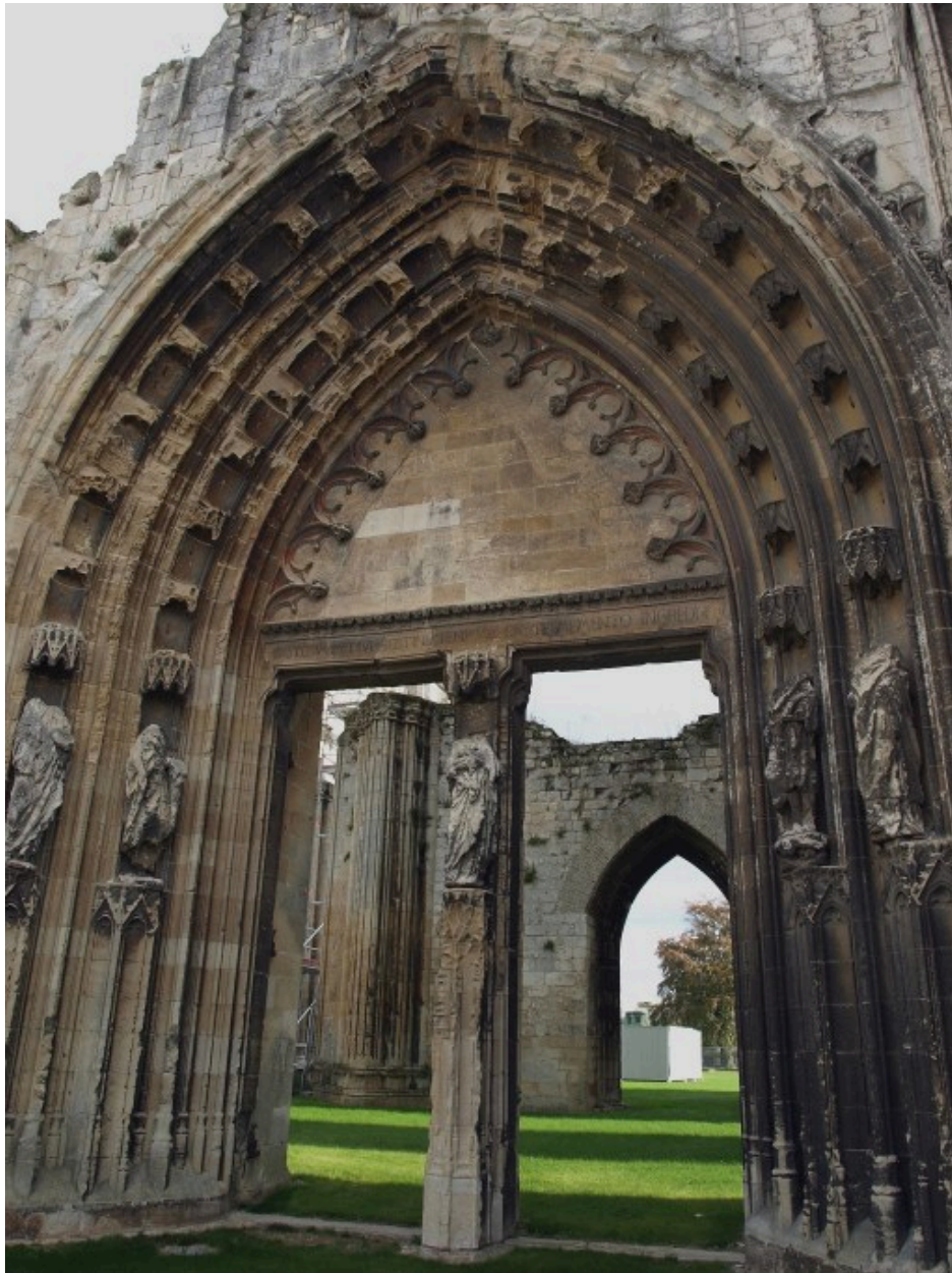
Vue d'ensemble du portail ouest
