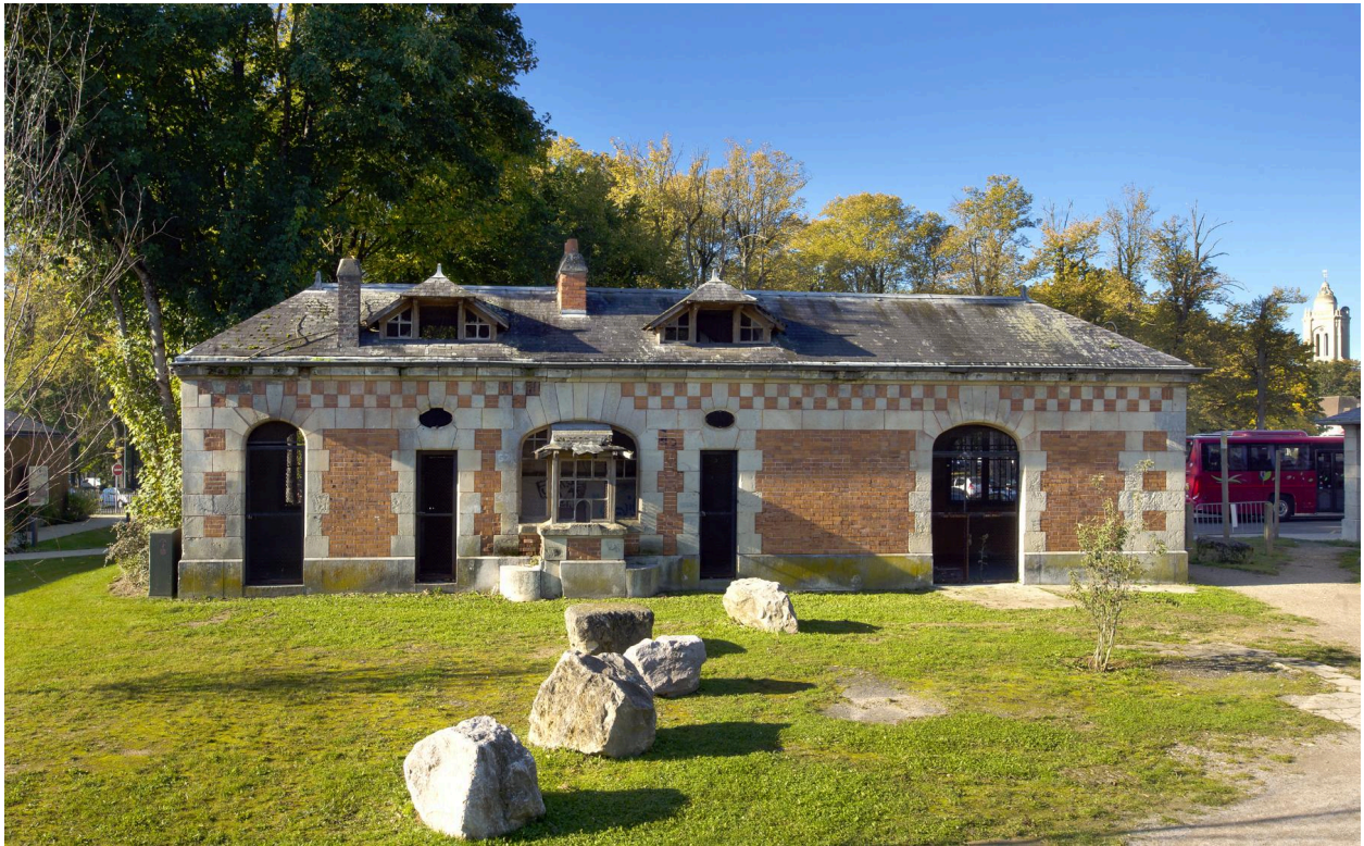
Bâtiment secondaire de la gare, servant de consigne annexe, implanté le long des quais.
