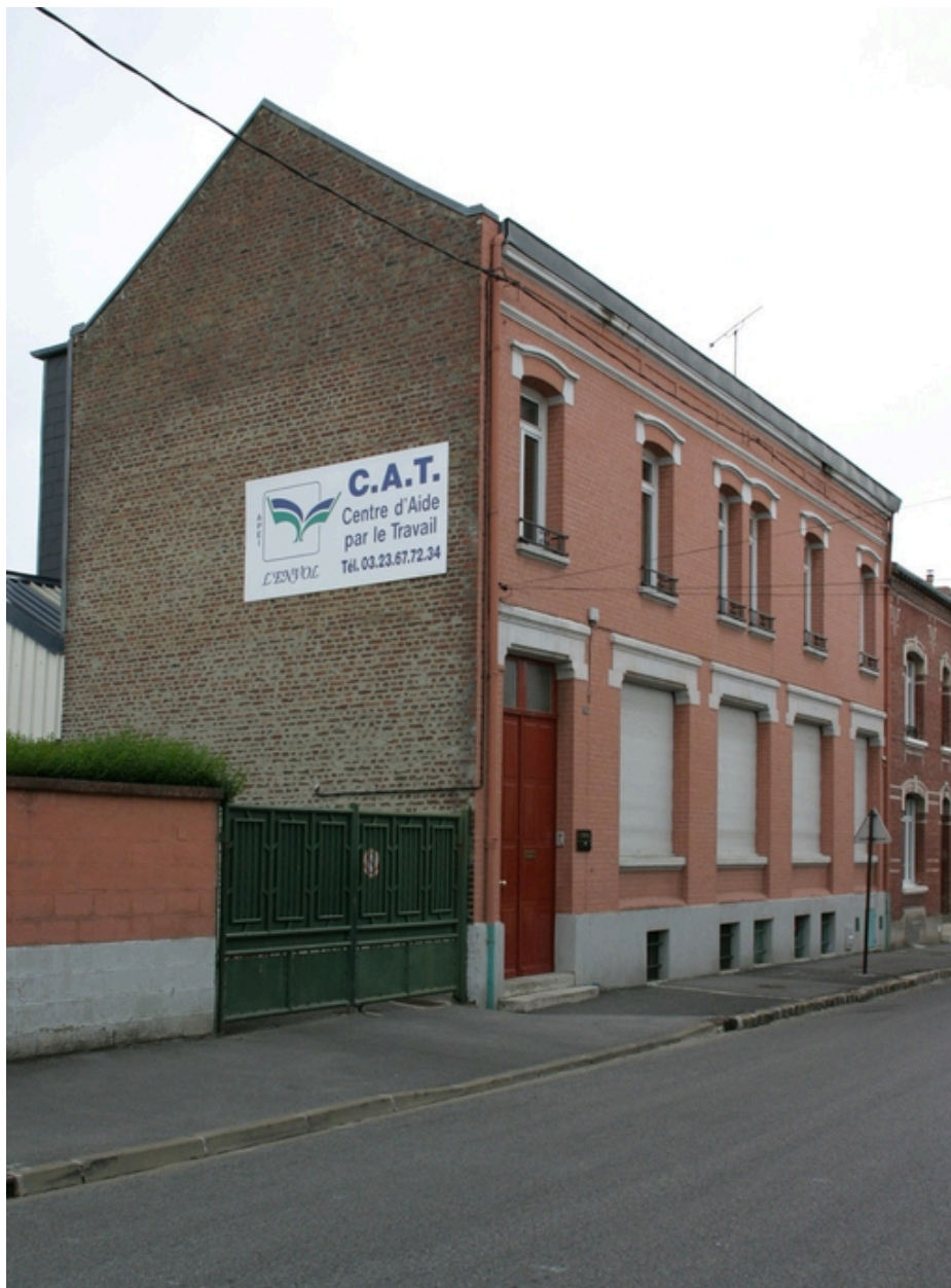
Façade des bureaux et ateliers, rue de Lunéville.
