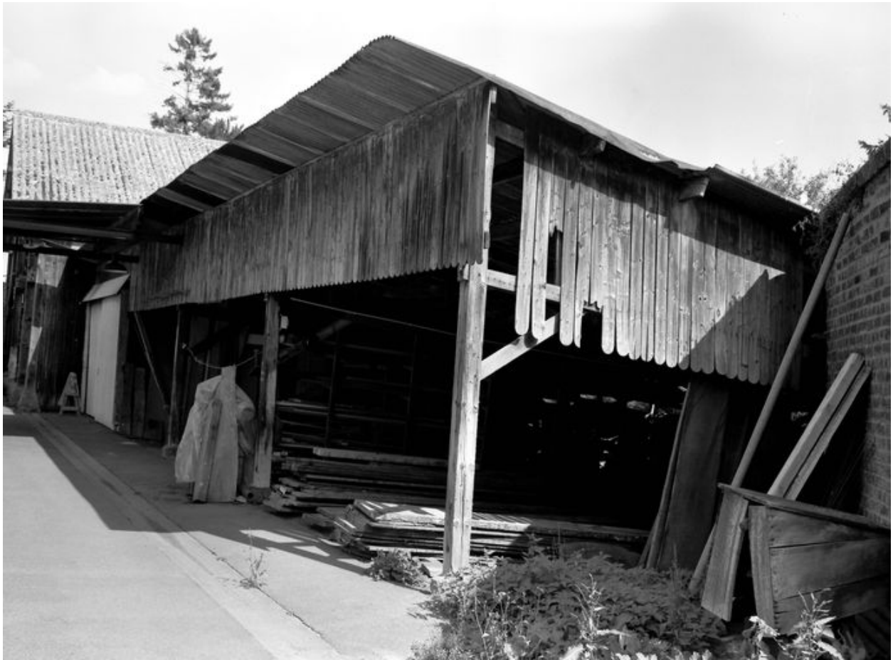
Entrepôt industriel, pignon nord-ouest.
